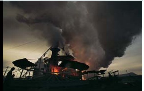
Ein kleiner Hochofen in Wuhei (China) lässt seine Abgase frei in die Luft. Die vorgeschriebene Filteranlage über der Brennkammer hat der Betreiber, wie es viele tun, ausgeschaltet. Um Kosten zu sparen
