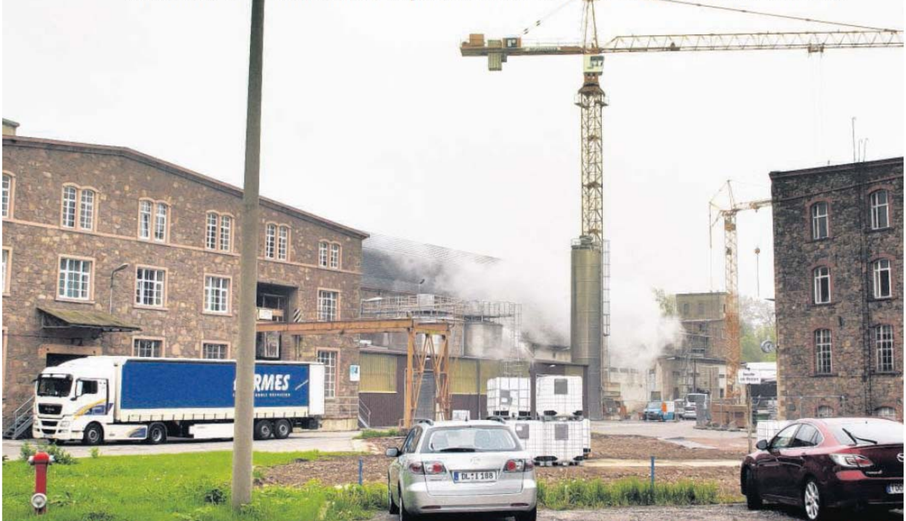
Die größte Werkhalle der Kübler & Niethammer Papierfabrik in Kriebstein bekommt ein neues Dach. Rund drei Millionen Euro investiert die Unternehmensführung in dieses Vorhaben. Foto: Wolfgang Sens
