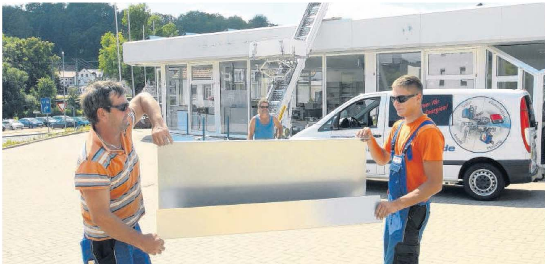
Bevor die Solarmodule montiert werden können, gilt es, die dafür notwendigen Gestelle zu installieren. Franco May (l.) und Peter Trautmann von der Chorener Firma Wagner übernehmen das gerade am ehemaligen Leisniger VW-Autohaus, das jetzt der Firma AEL gehört. Auch die anderen AEL-Gebäude haben schon Module auf den Dächern. Foto: J. Kulschewski
