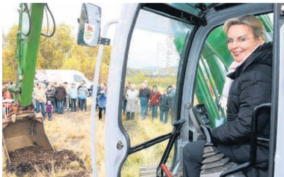
Veronika Bellmann hat ihren Stuhl im Plenarsaal gegen den Arbeitsplatz im Bagger getauscht. Schließlich soll es vorwärts gehen mit der Ortsumgehung. Foto: Dirk Wurzel
