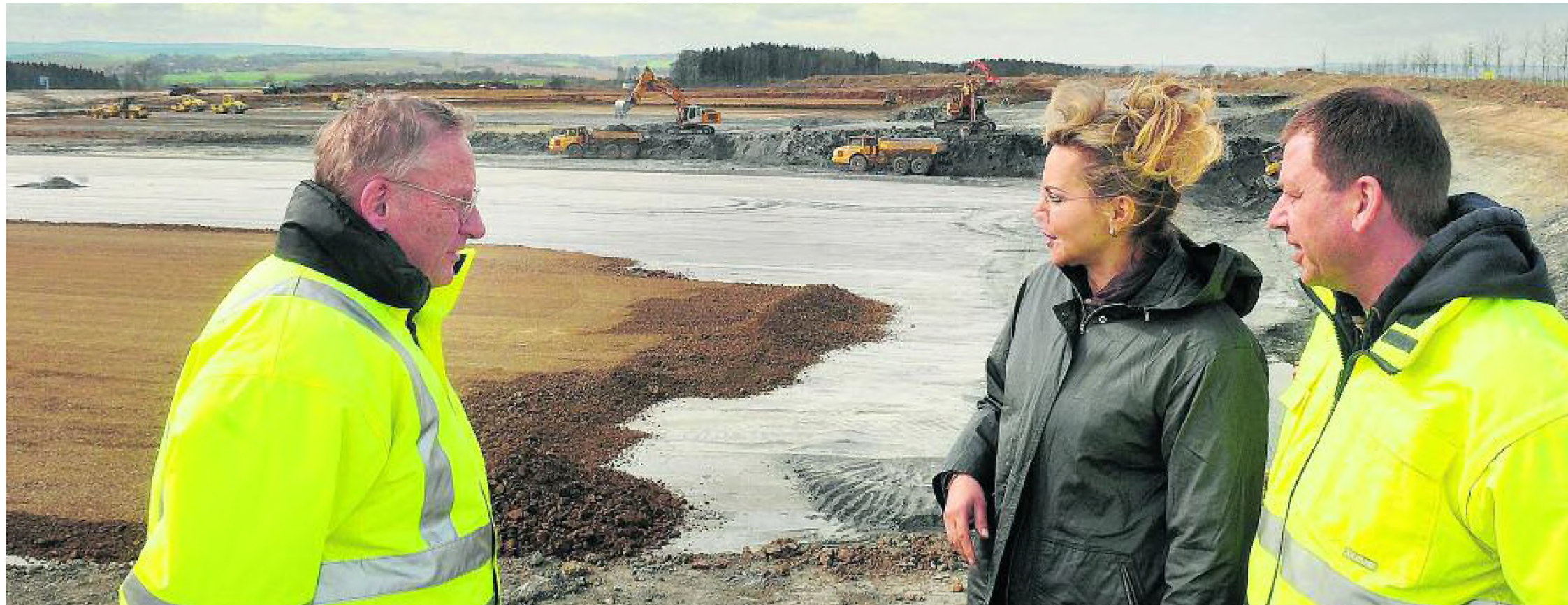
Baustelle für das Edeka-Großlager in Berbersdorf. CDU-Bundestagsabgeordnete Veronika Bellmann im Gespräch mit Klaus Thürmer (l.) und Oberbauleiter Dirk Haferkorn.
